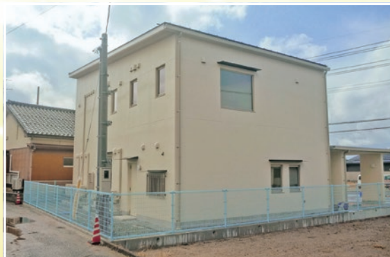
工事名 米子警察署旗ヶ崎交番新築工事（電気設備） 規模 電灯・構内情報通信網・構内交換・誘導支援・テレビ共同通信・監視カメラ・火災報知・防犯入退室管理・構内配電線通信線路 各設備 施工会社 松田電工有限会社
