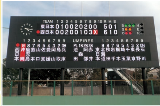
工事名 鳥取市営美保球場スコアボード更新（電気）工事 規模 高輝度フルカラーLEDスコアボード設置に係る電気設備工事 一式 施工会社 吉備総合電設・カドヤ電設 特定建設工事共同企業体
