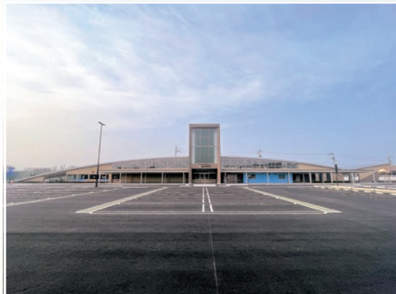
工事名 道の駅北条公園駅舎外新築工事（電気設備） 規模 受変電設備（総容量450KVA）、発電設備（低圧ディーゼル90KVA）、電灯・動力・構内配電線路・構内通信線路・構内交換・拡声設備・誘導支援・テレビ共聴・監視カメラ・自動火災報知 各設備 施工会社 株式会社エナテクス
