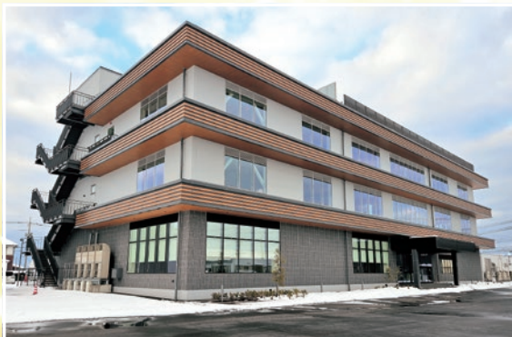
工事名 中海テレビ放送新社屋新築工事 規模 構造規模 S造4F 増築部 新社屋：3,153.41㎡ 車庫：20.02㎡ 駐輪車庫：19.39㎡ 施工会社 岡田電工株式会社（電気設備工事）
