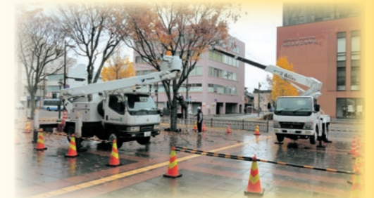
イルミネーション撤去作業
